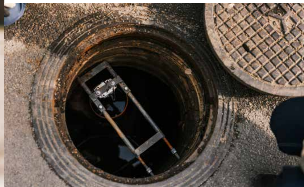
▲ I Ryd i Tingsryds kommun är åtta brunnar utrustade med sensorer som mäter vattennivån.
