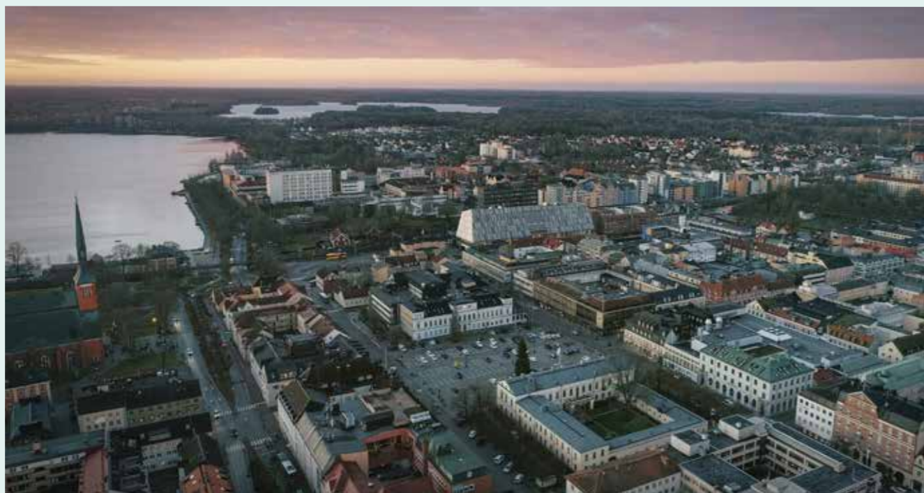
> Flygbild över Växjö, där kraftvärmen i Sandviksverket förser staden med både el och fjärrvärme. Under 2025 producerades 164 GWh el lokalt i staden.
